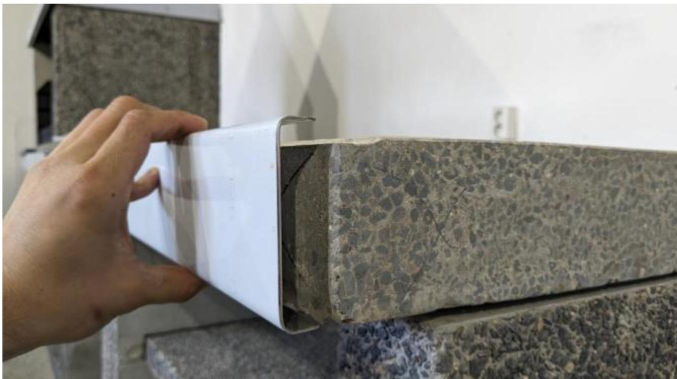
11. Уложите гранит на всех модулях по уровню. Используйте белый клей для камня и гранита. Уровень при установке гранитных столешниц можно регулировать толщиной клея. При необходимости, аккуратно придавливайте/подбивайте гранитные части резиновой киянкой. Допустимые стыки между гранитными частями разных модулей - не более 1мм.
