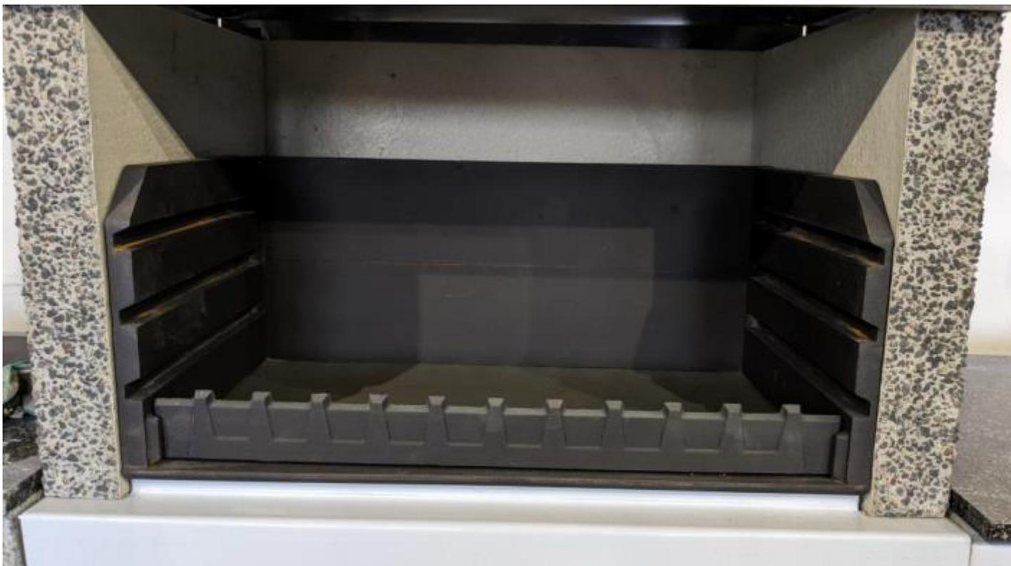
10. Установите фронтальную панель модуля «Жаровня» из нержавеющей стали, используя плиточный клей или герметик.
