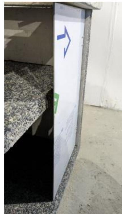
13. Щели между гранитными столешницами необходимо затереть тем же раствором, что использовали для укладки гранита. Чтобы не оставлять следов и сделать шов ровным и красивым - используйте двухсторонний скотч, как показано на картинке.
