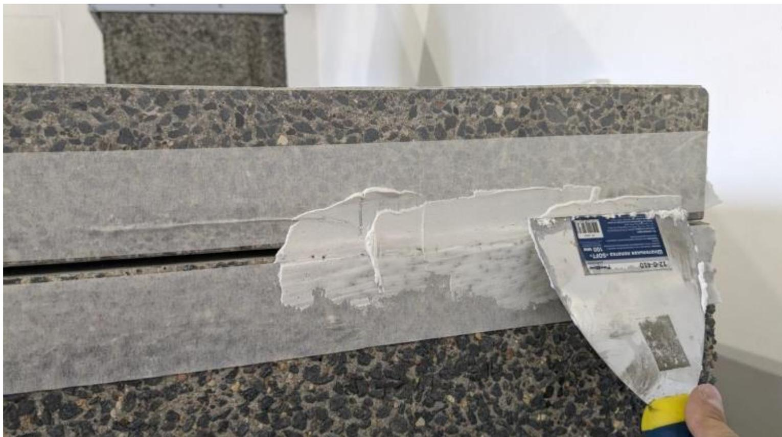
14. Внутри секции можно скрепить также как и столешницы - с помощью раствора или же использовать герметик.
